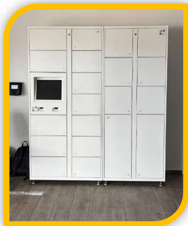
SMART LOCKER installato presso Depuratore Roma Est
