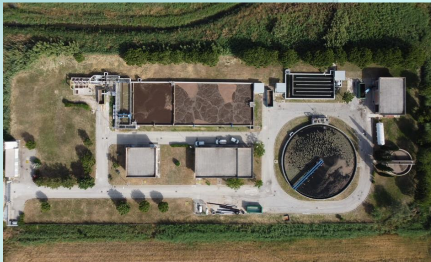
Fig1. Stato di fatto dell'impianto di depurazione "Pantano".
