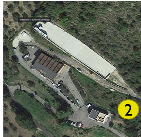
Campo Pozzi Capo d'acqua Castrocielo
