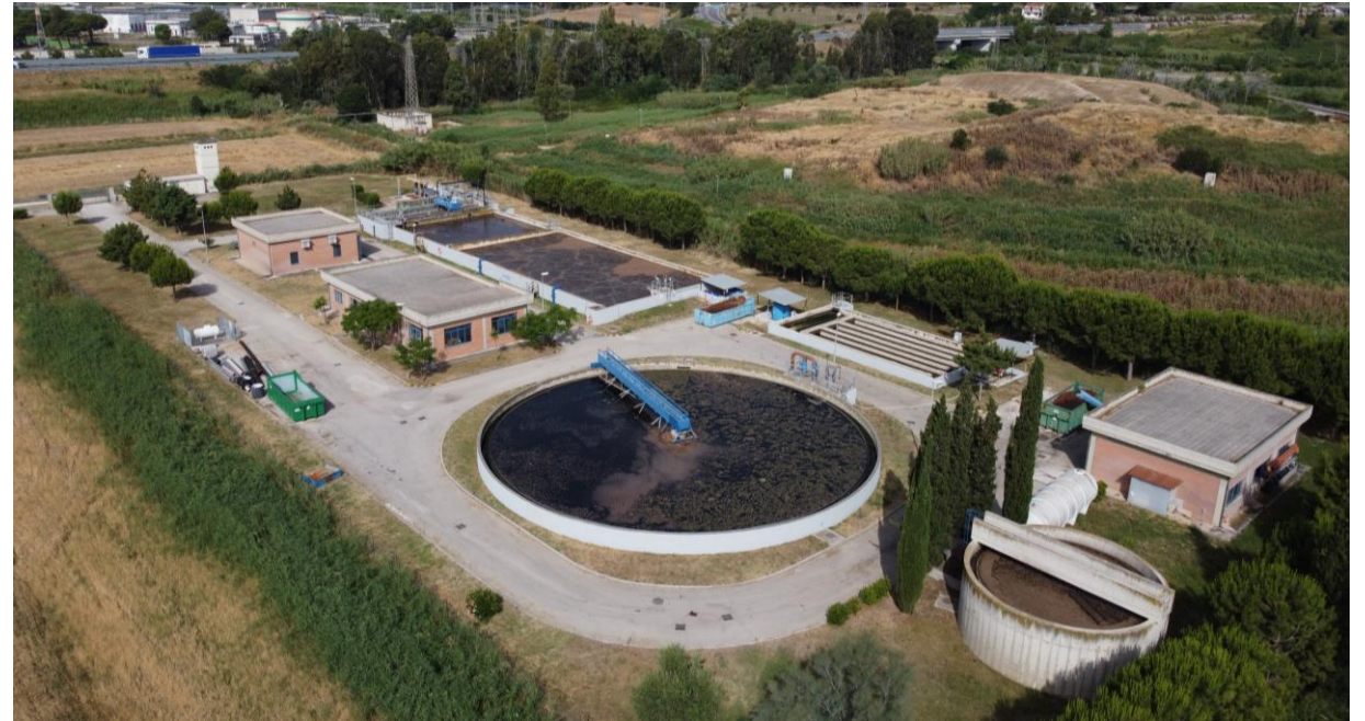
Fig. 1 Stato dei luoghi dell'impianto di depurazione «Pantano»
